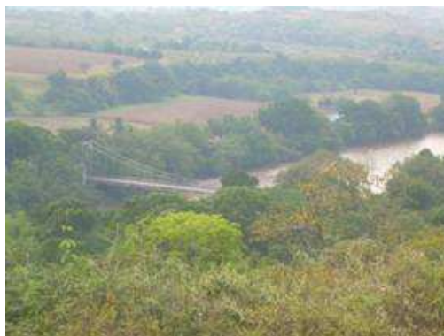
Fotografía 104 . Puente EL Balseadero, construido en 1952
