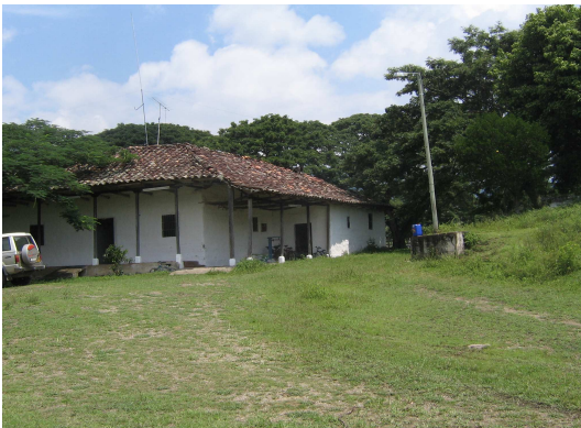
Fotografía 261 Casa de la Finca El Kiosco, vereda Bajo Buenavista
