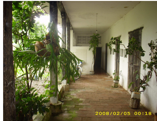
Fotografía 262 Interior de la casa paterna de la finca Buenavista
