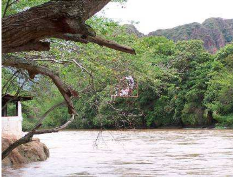
Panorámica de tarabita sobre el río Magdalena. A la izquierda se aprecia una estructura de bombeo para riego.
