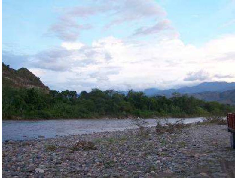
Río Magdalena - Puente Balseadero
