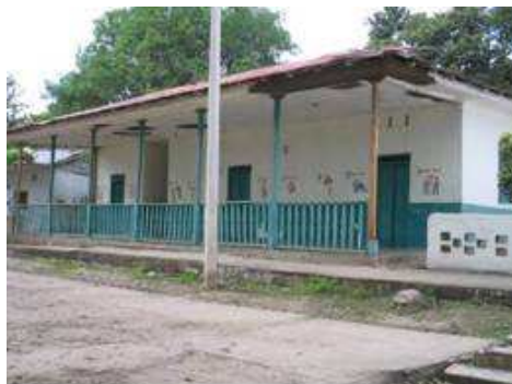
Fotografía 103 Casa cural y antigua escuela anexas a la Capilla de San José de Belén.
