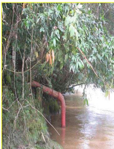
Fotografía 276 Bocatoma en el río Magdalena
