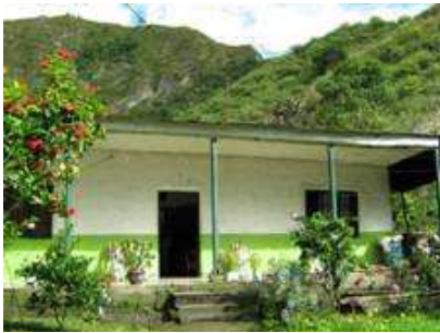
Fotografía 20 Vivienda con techo en dos aguas
